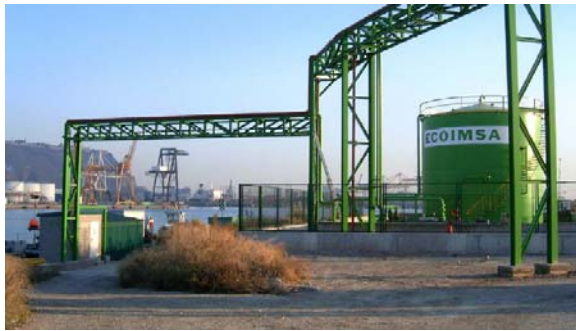
Figura 11: Planta de tratamiento de residuos Marpol de Ecoimsa, en el Puerto de Barcelona (fuente: www.apb.com).
